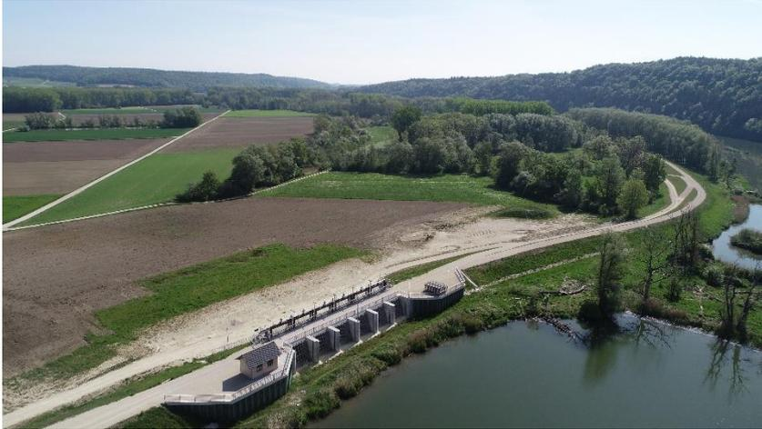
in den Stauhaltungsdammbauwerk der Staustufe Bittenbrunn integriertes Einlaufbauwerk zur Polderfüllung (Quelle: Wasserwirtschaftsamt Ingolstadt)
